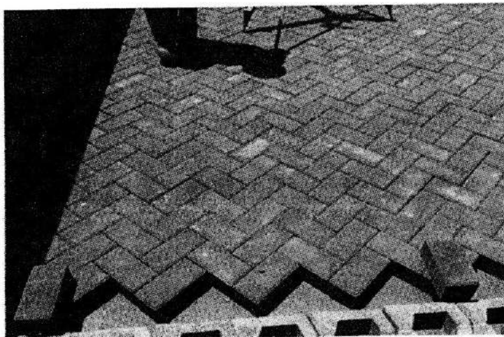
FIGURA 2: Detalhe do piso intertravado retangular na cor vermelha.
